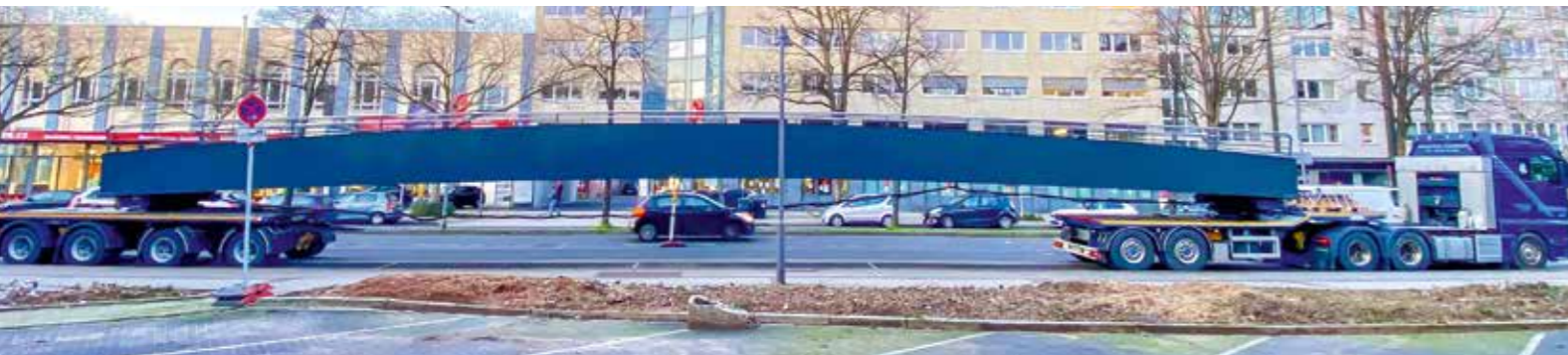
Die 33 t Stahlbrücke wird angeliefert.
