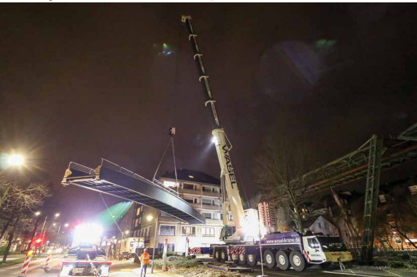
33 t am Haken – Vorbereitung für den Tandemhub.
