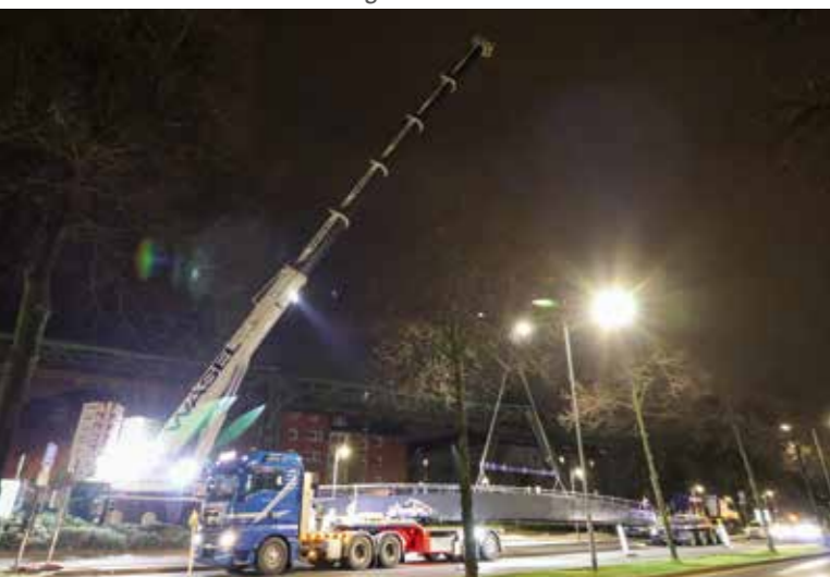
Vorbereitung für den Präzisionshub.
