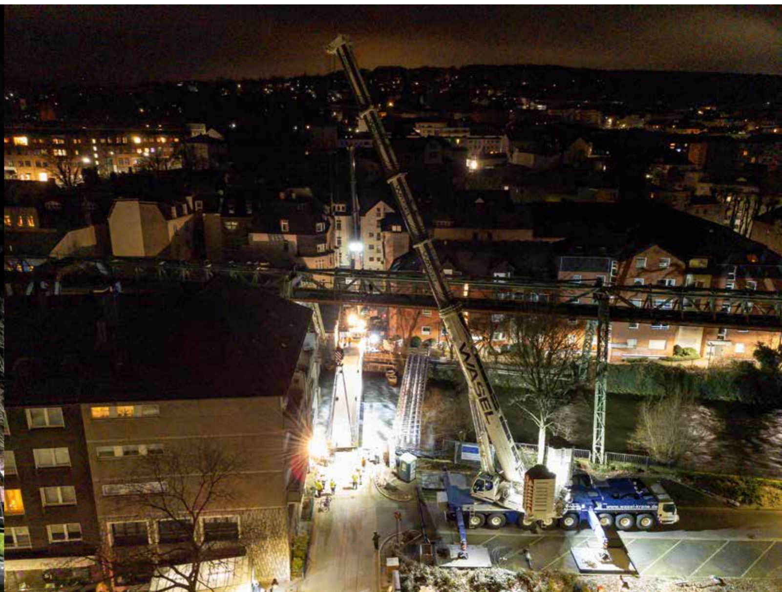
Nächtliche Teamarbeit unter der Schwebbahn mit dem LTM 1450-8.1 und dem LTM 1130-5.1.
